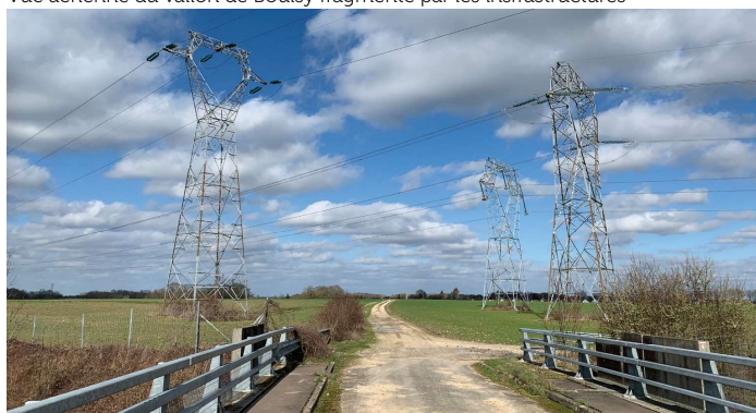
Traversée aérienne de l'A5 vers Blandy
