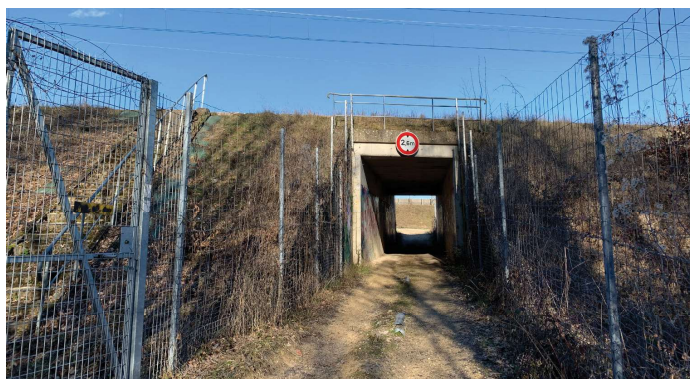
Passage sous le talus de la LGV
