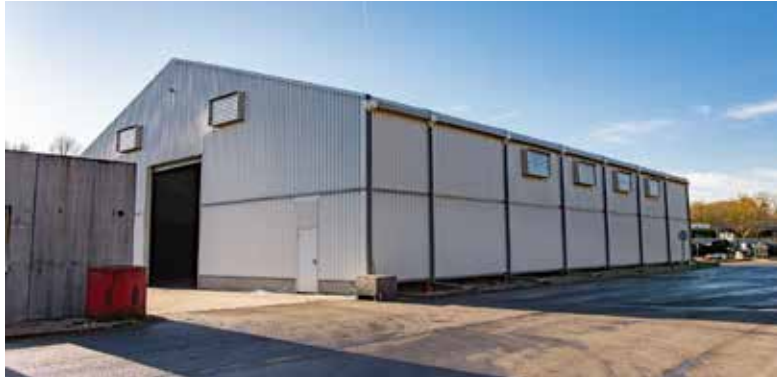
Quai de transfert
